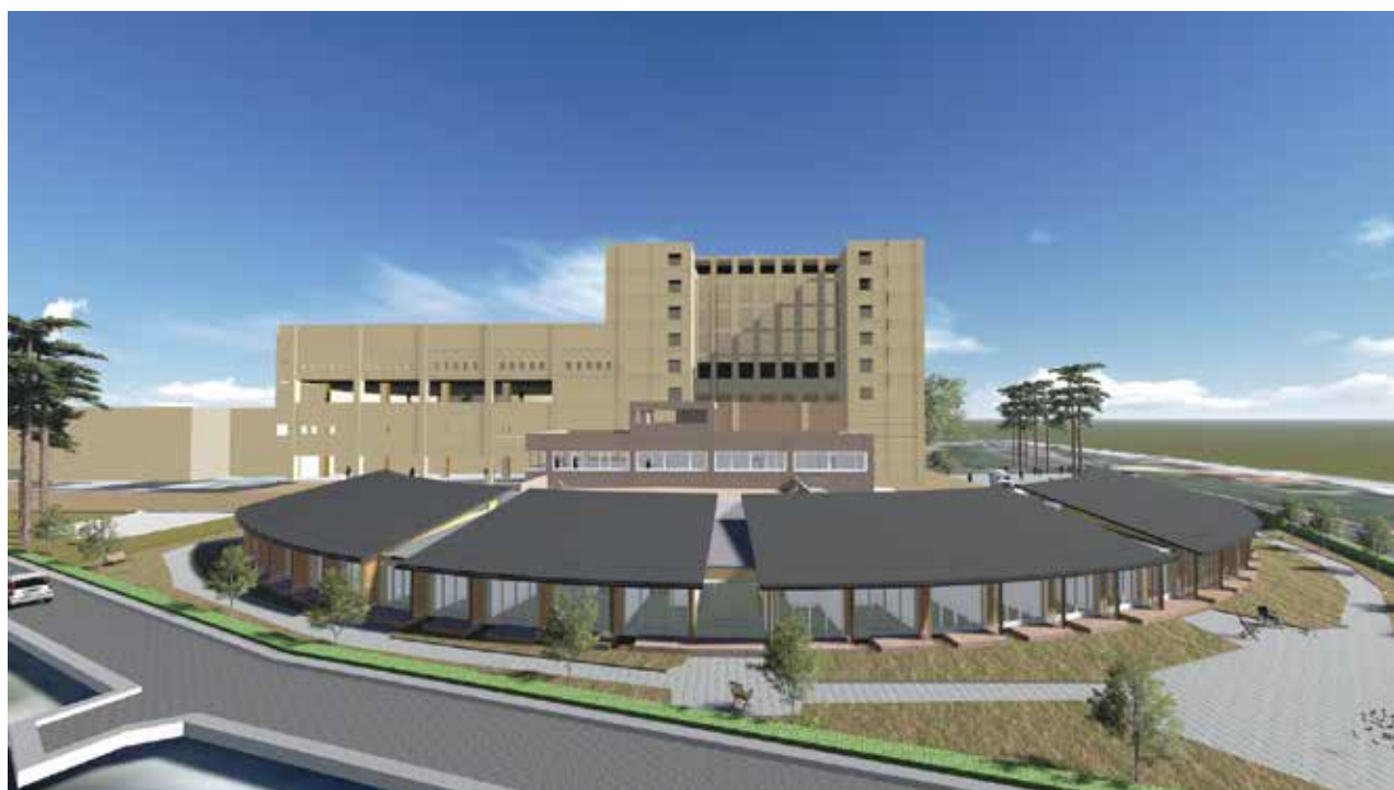
西側からの風景（手前が新病棟、奥が本館）
